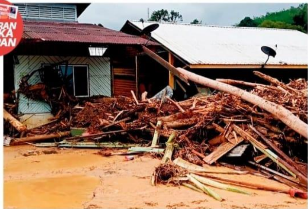
Sisa kayu turut membadai kediaman penduduk berdekatan Sungai Telemong, Bentong, Pahang.
